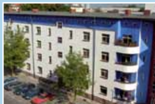
Heinz-Bartsch-Straße 99 Wohneinheiten 1920er Jahre
