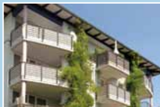
Lüdeckestraße 401 Wohneinheiten 1960er und 1990er Jahre
